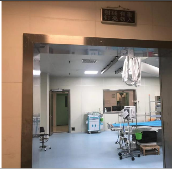
DSA 机房病人防护门（开门）
