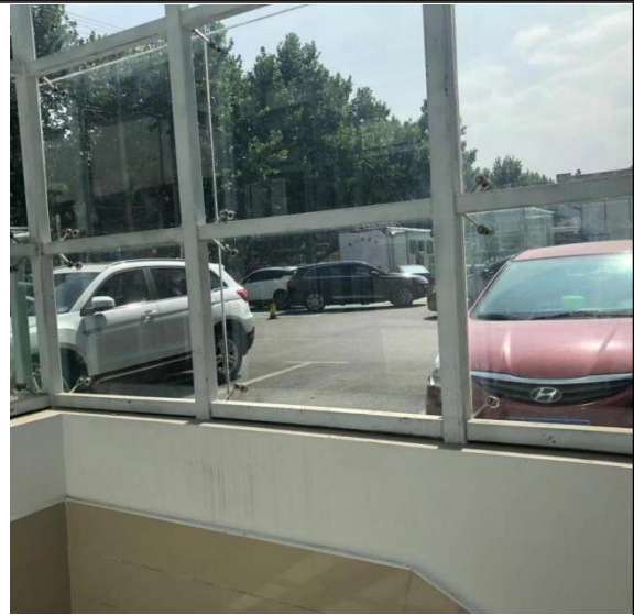
直线加速器机房正上方
