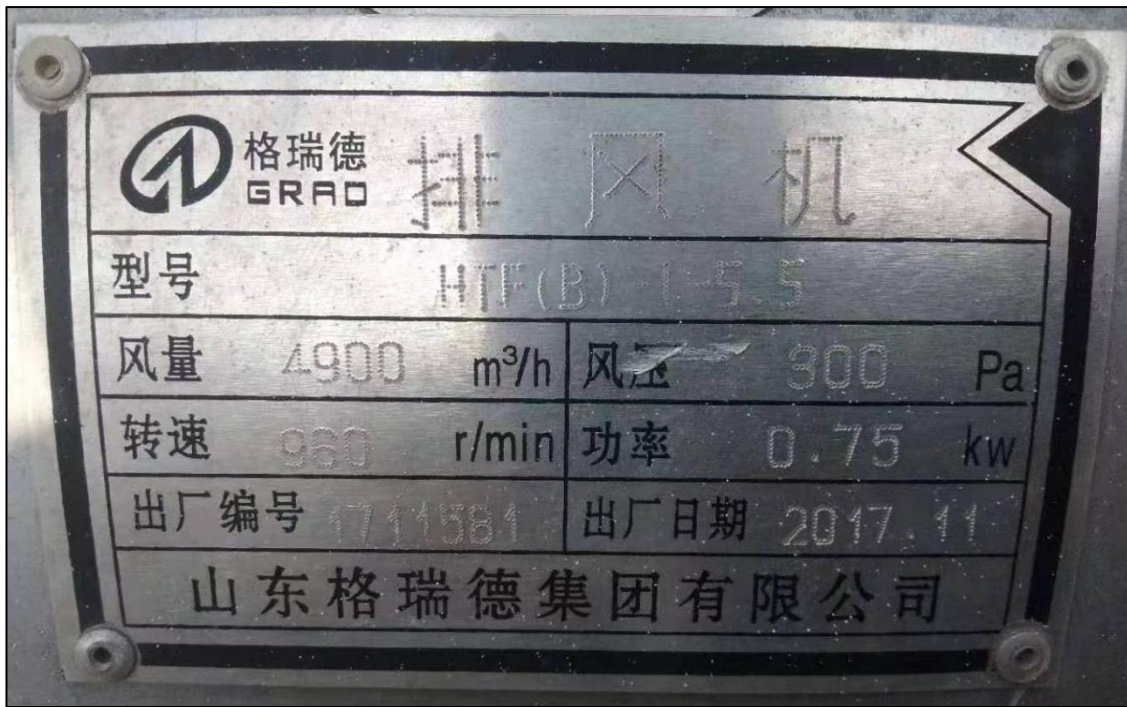
图 2-5 加速器机房排风机设备参数铭牌
