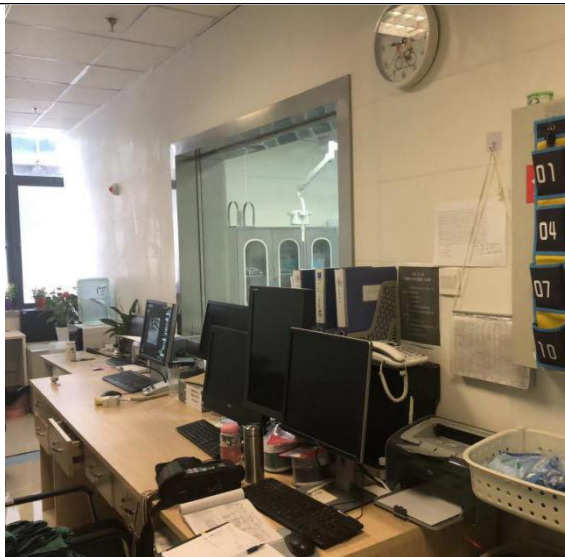
DSA 机房西侧控制室、防护铅窗
