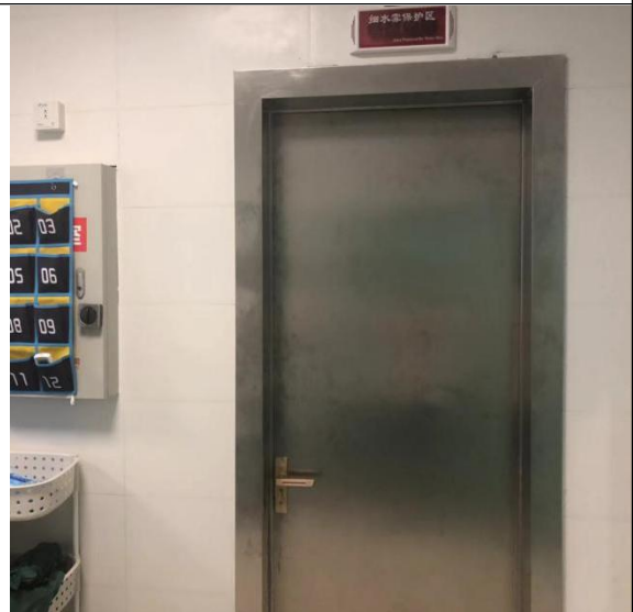
DSA 机房医生防护门
